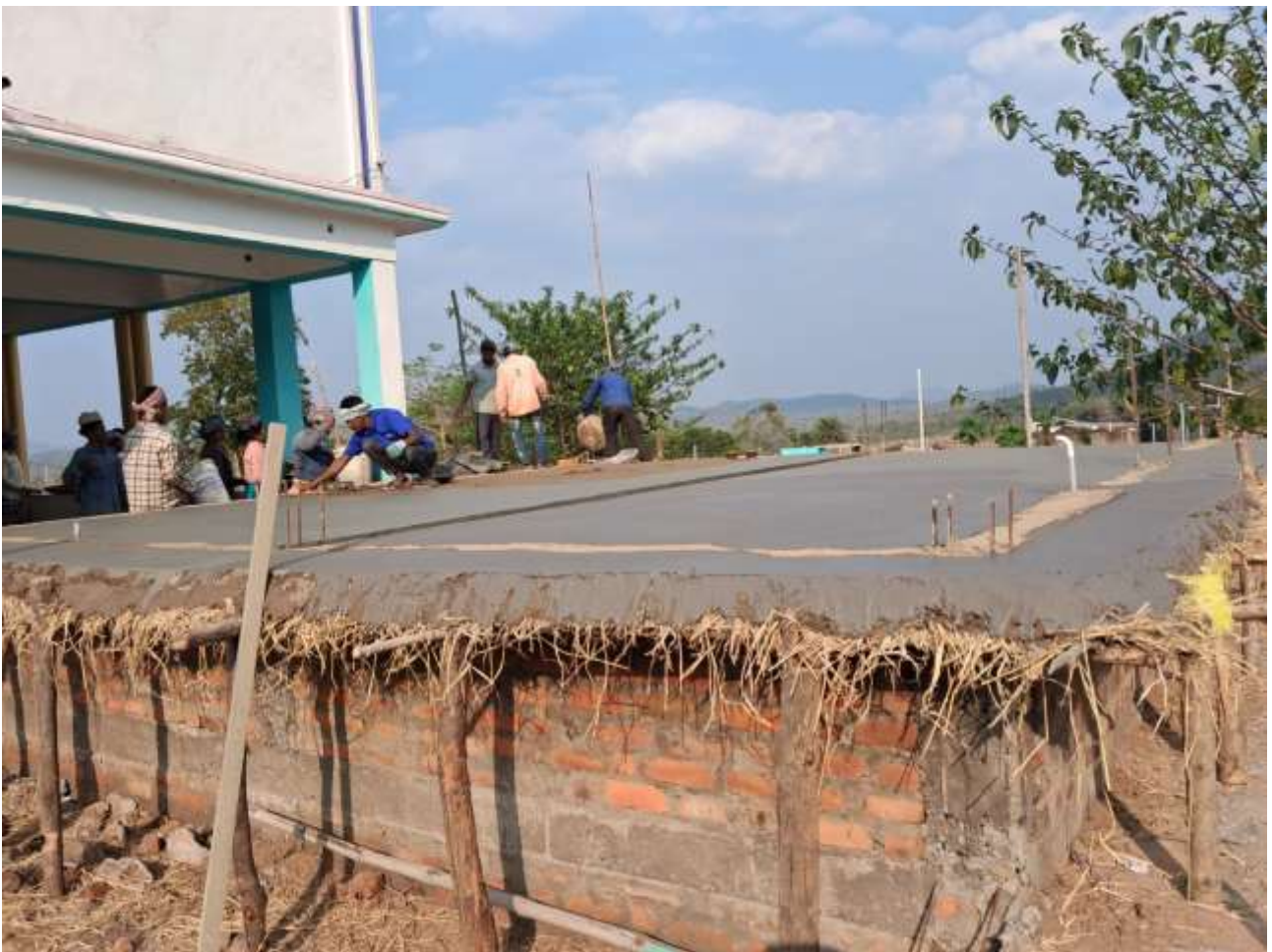
Der Bau des Gemeinschaftshauses in Ruaamba ist in vollem Gange. Jedes Modelldorf befindet sich in stetiger Entwicklung – sie kennt kein Ende.
