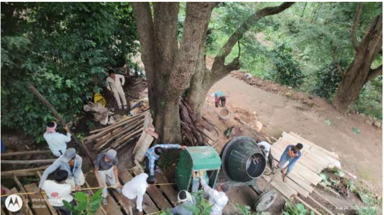
Die Kraft der AMPU-Gemeinschaft: Mit vereinten Kräften ziehen die Bewohner eine Betonmischmaschine für den Hausbau in den oberen Teil von Gudanggorjang hinauf. Geschafft. Großartig.
